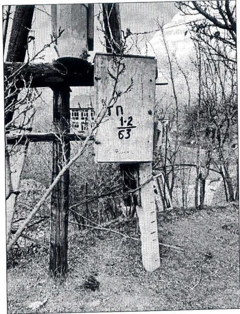
По результатам осмотра ВЛ 0,4 кВ Ф-1 МТП-1-2/63 была выявлена однофазная перемычка между проводом ВЛ 0,4 кВ Ф-1 КТП-1-1/400 и проводом ВЛ 0,4 кВ Ф-1 МТП-1-2 ВЛ-10 кВ Ф-1 ПС 35 кВ Каата, что послужило способом
